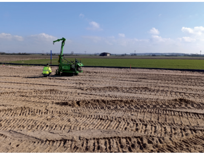
Baugrunderkundung im Gelände
