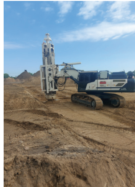
Impulsverdichter im Baustelleneinsatz (aus der Masterarbeit von Laura Hübler)
