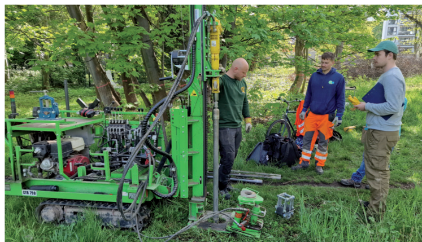
Baugrunderkundung im Projekt Geotechnik durch institutseigene Ramm- und Rammkernsondiertechnik
