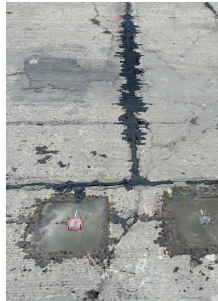
*Testeinbau von Beschleunigungssensoren mit Bitumen und Epoxidharz auf der Tragschicht*
